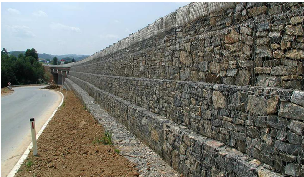
Zaštita od klizanja – opterećivanje kamenim zidovima, Vukova Gorica
