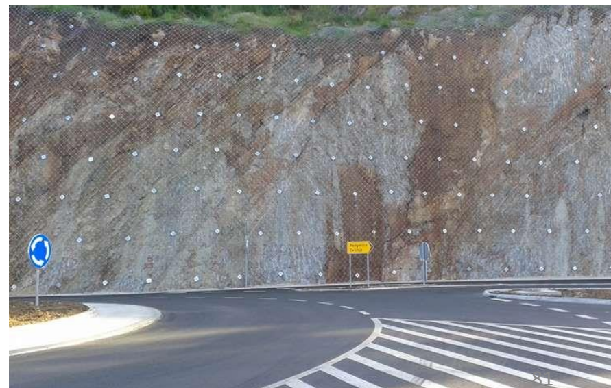
Zaštita od odrona – zaštitna mreža i sidrenje
