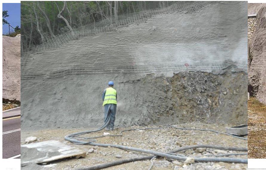
Zaštita od odrona – betoniranje padine („torketiranje”), tunel Klis-Kosa
