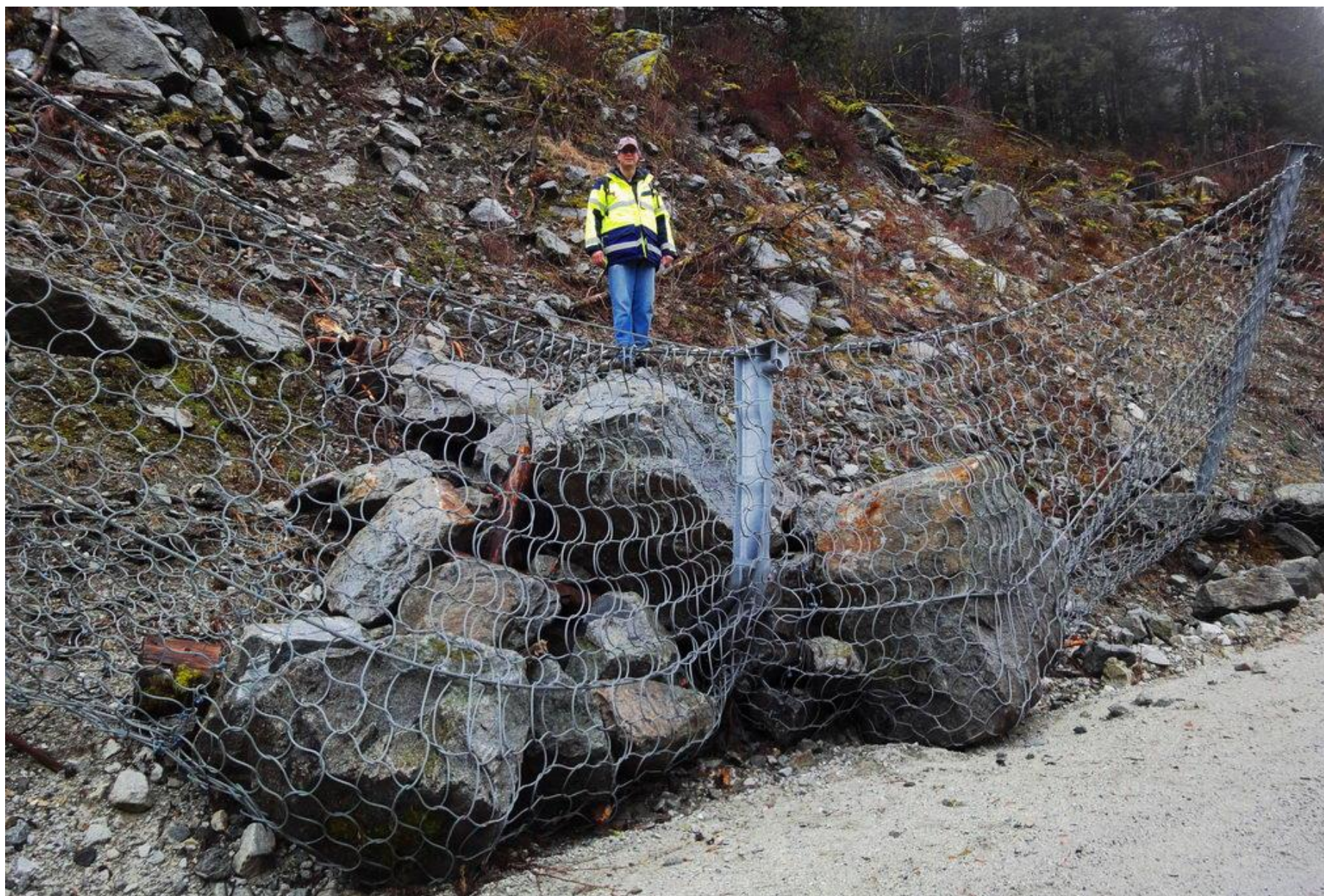
Mreža je zaštitila prometnicu (i vozače) od odrona
