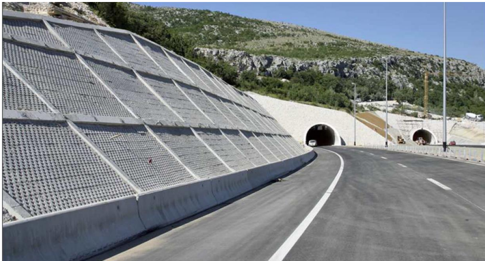
Zaštita od odrona – betonski podzidi, tunel Konjsko
